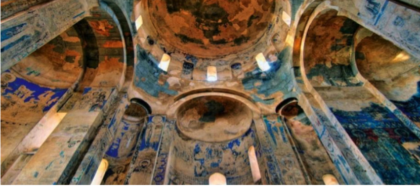
Görsel 70. Akdamar Kilisesi İç Mekân Süsleme Onarım Görünüşü (Ş. Öztürk)
