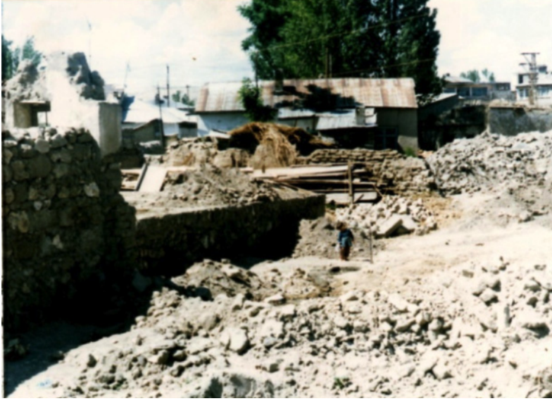
Görsel 3. Çavuşoğlu Samanlığı Temel Kazısı Alanı Genel Bir Görünüm (VMA 1988)
