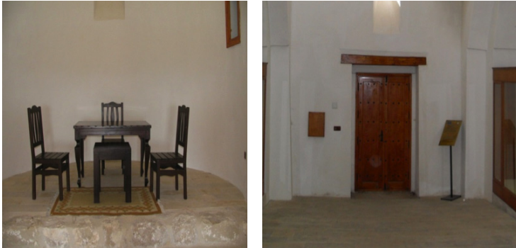
Görsel 311-312. Edremit Kilisesi İç Mekân Onarım Sonrası Görünüşleri (Ş. Öztürk)
