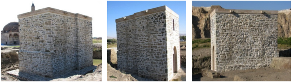
Görsel 282-284. Surp Diziranavor Kilisesi Onarım Görünüşleri (Ş. Öztürk)
