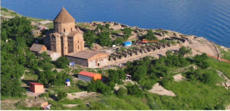
Görsel 66. Akdamar Kilisesi Onarım Çalışmaları Genel Görünüşü (Ş. Öztürk)
