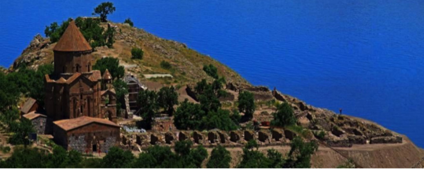
Görsel 65. Akdamar Kilisesi Onarım Çalışmaları Genel Görünüşü (Ş. Öztürk)
