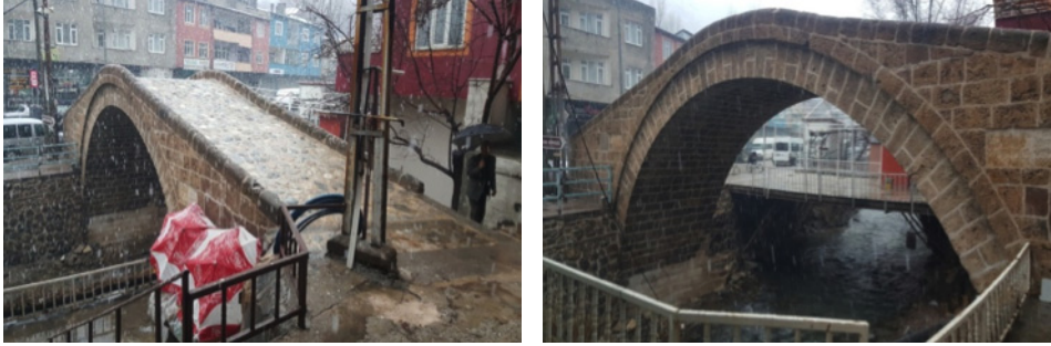
Görsel 384-385. Çatak Merkez Köprüsü Mansap Cephe ve Döşeme Görünüşleri (Ş. Öztürk)
