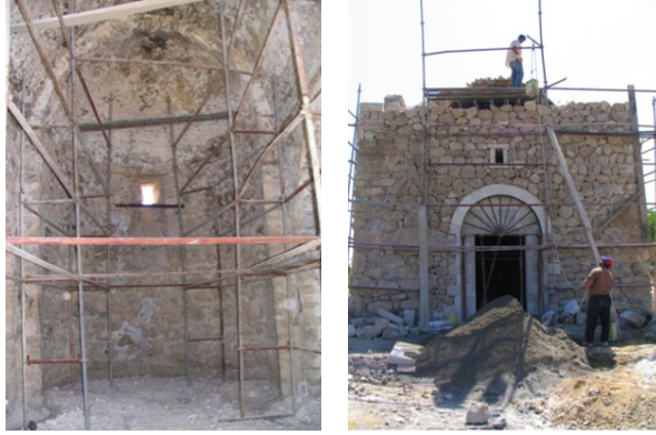
Görsel 309-310. Edremit Kilisesi İç Mekân Apsisi ve Batı Cephe Onarım Görünüşleri (Ş. Öztürk)
