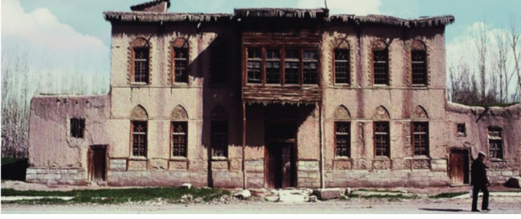
Görsel 504. Polat Yörükoğlu Evi Güneybatı Görünüşü (Ş. Öztürk)
