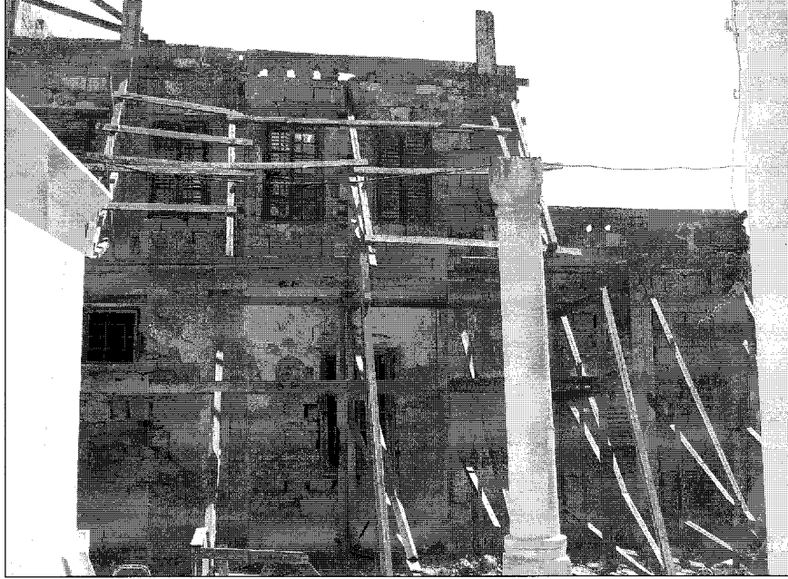
Murad Reis Tekke binasının ön cephesinin görünüşü (2007).
