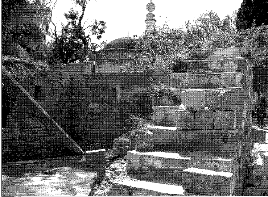
Murad Reis Tekkesi Haremlik binasının yıkılmış hali (2009).
