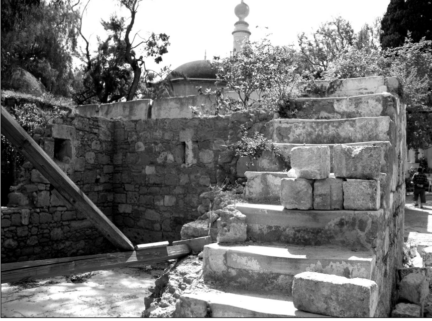
Murad Reis Tekkesi Haremlik binasının yıkılmış hali (2009).
